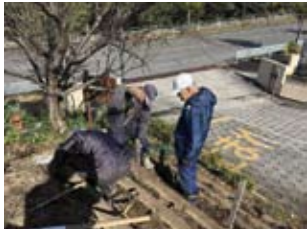
11/10 花壇の花を全て抜去し土留め板の修復も行った
